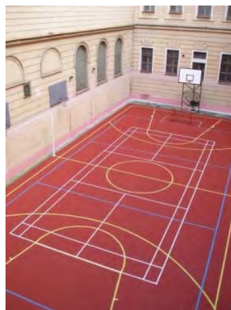
obr. Oprava hřiště
